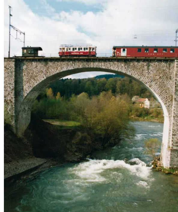
Le train de transfert sur le pont de la Glatt, près de Flawil, le 7.5.1982.
