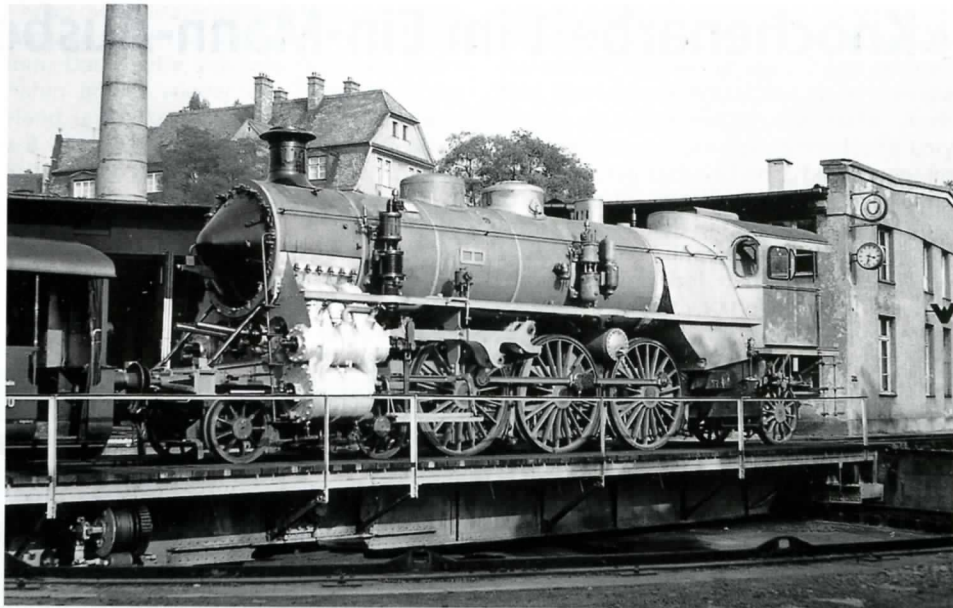
Bis auf Zylindererschaltungen und Triebwerk ist die Lok fertig montiert. Gut sichtbar ist auch ein C 5/6-Aufstieg. Fotos: S. Lory, Sammlung WEA
